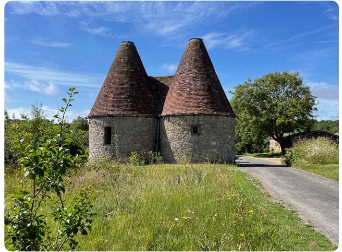
Diesen betagten Hopfendarren bei East Farleigh fehlen bereits die Windschutz-Hauben und etliche Ziegel.
